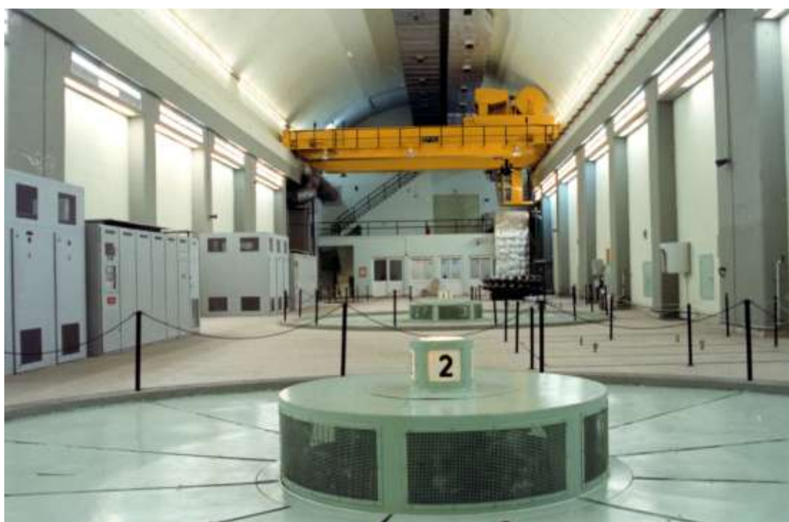
Φωτ. 2: Σταθμός Παραγωγής – Άποψη από μονάδα Νο. 2
