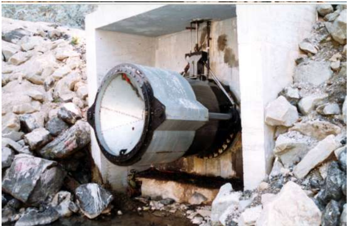
Φωτ. 6: Βαλβίδα διασποράς εκκενωτή κλειστή
