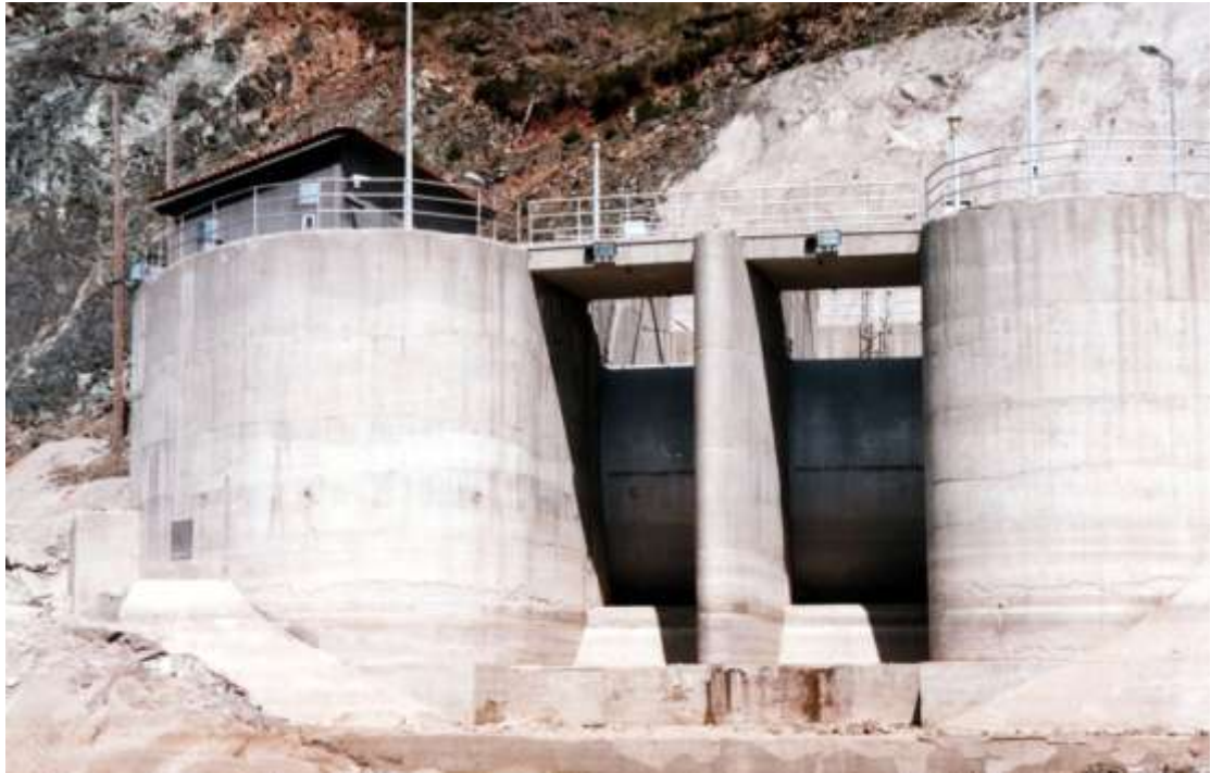
Φωτ. 5: Θυροφράγματα εκχειλιστή μέσα από τη λίμνη
