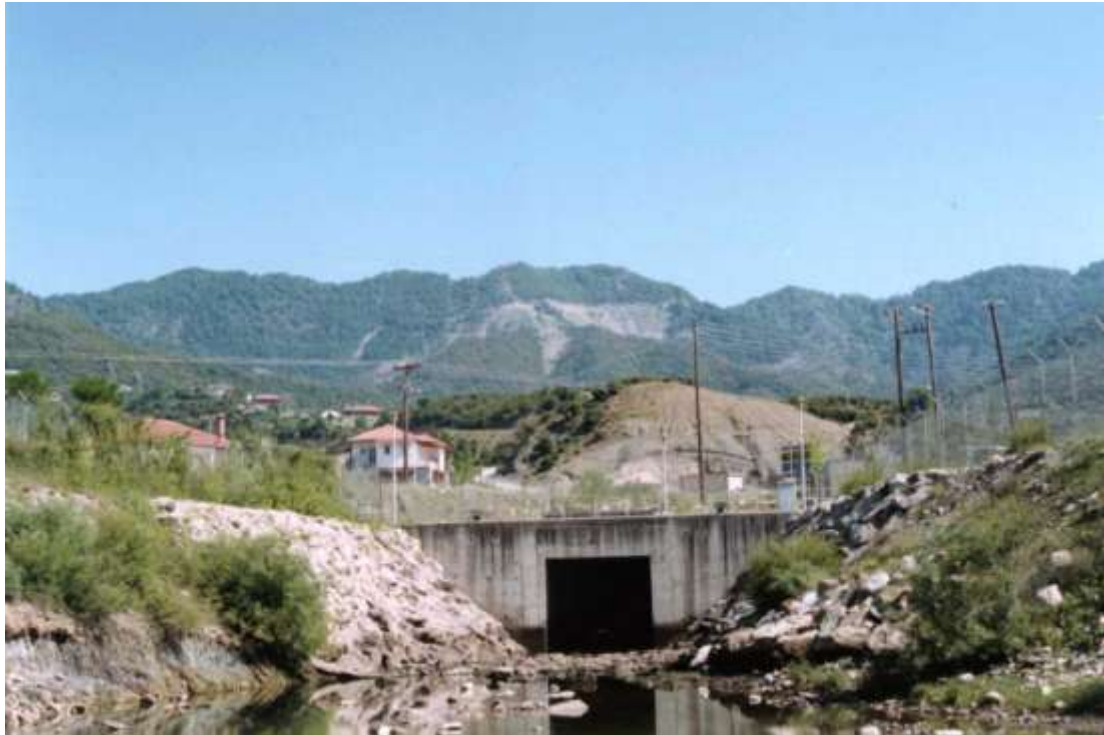
Φωτ. 9: Έξοδος Αγωγού Φυγής
