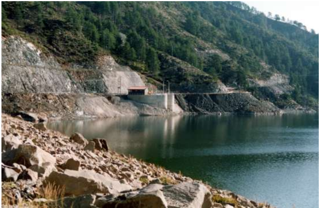
Φωτ. 4: Άποψη εκχειλιστή από το κύριο φράγμα
